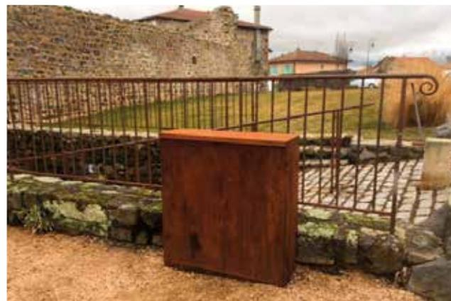
L'entreprise JOLIVET serrurerie a façonné deux caches coffres électrique en ferronnerie en aspect rouillé semblable à la main courante.
